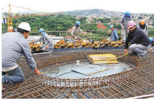
Obra conta com 120 trabalhadores, entre eles os que fazem preparativos para a concretagem da cúpula
